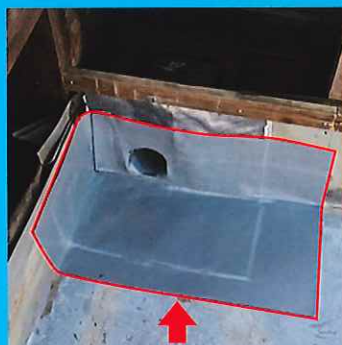
ドレン周りの補修
