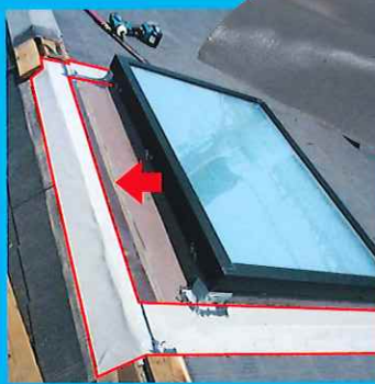
トップライト周りの改修
