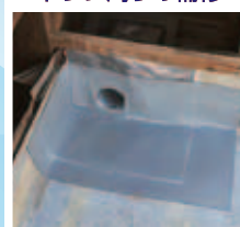
ドレン周りの補修
