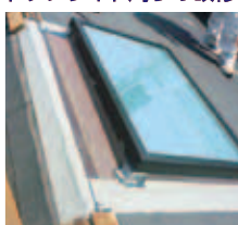
トップライト周りの改修
